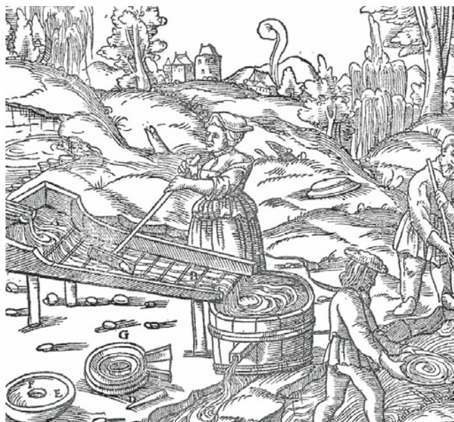
Obr. 2. Ryžovanie pomocou ryžovacieho žľabu (Agricola, De re metallica libri XII. , 1556; rytina)
